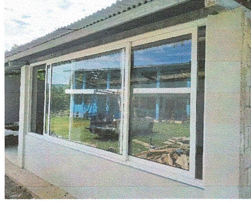
Foto 2: Mejoramiento con instalación de puertas, ventanas y balcones en proceso.
