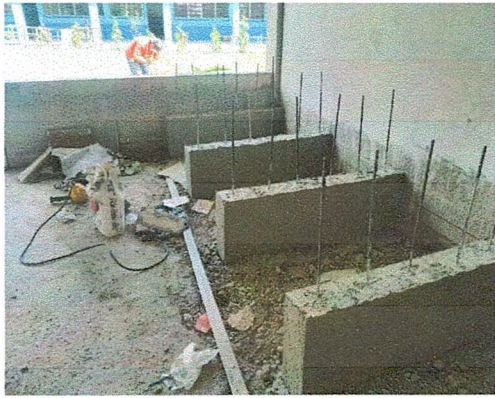
Foto 1: Mejoramiento con instalación de polletón y extractor de humo tipo campana en proceso.
